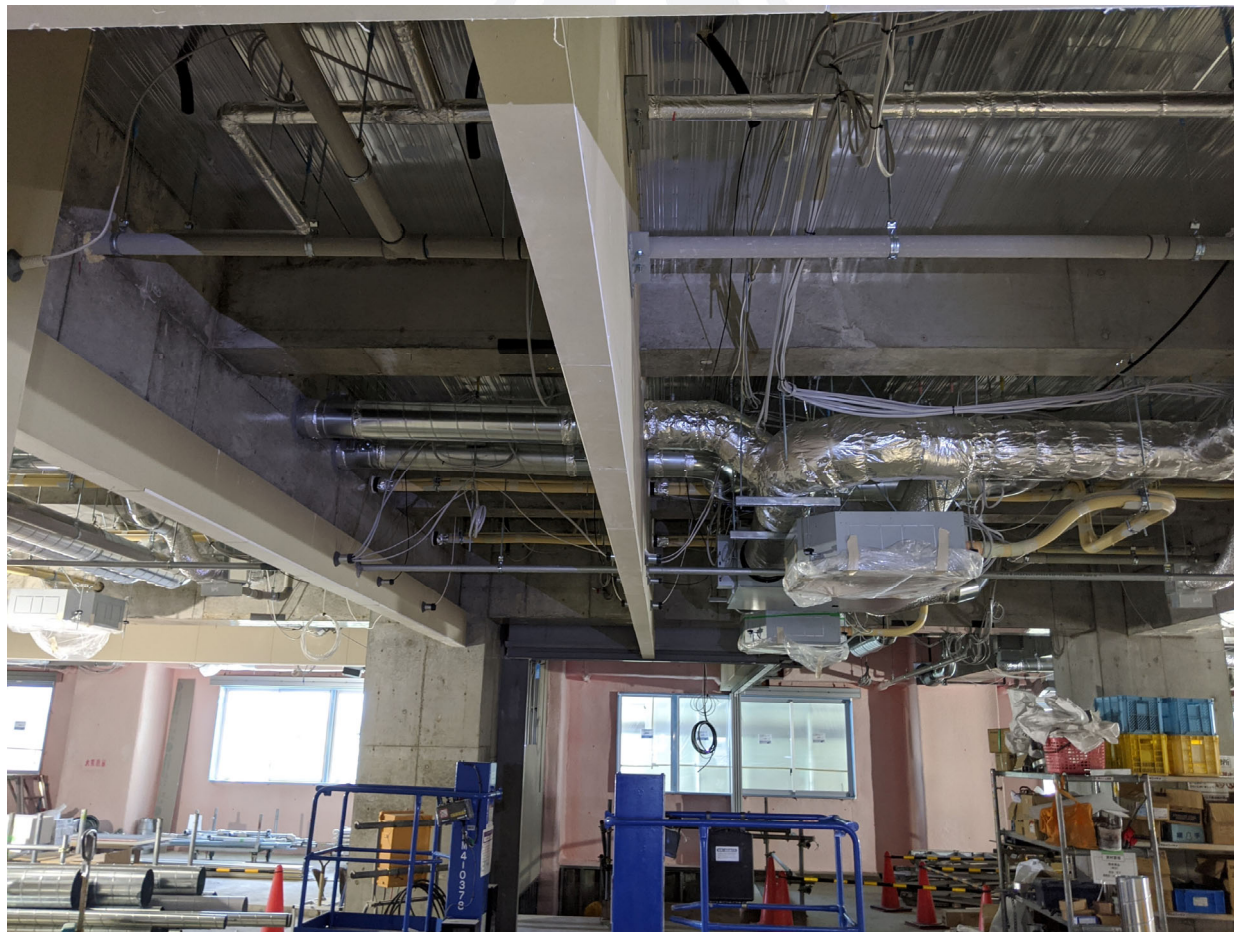
2020年6月 1階内装工事
