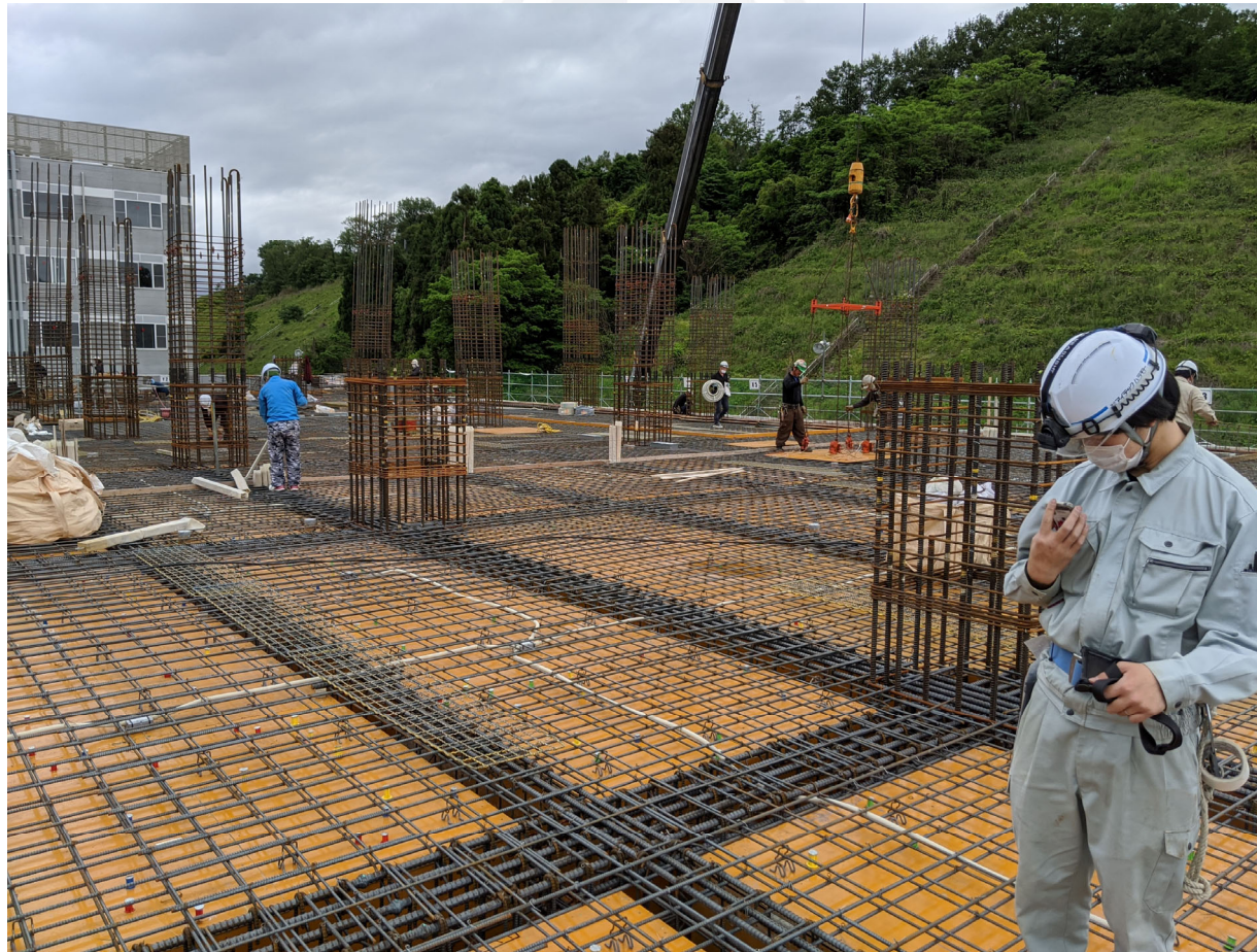
2020年5月 3階コンクリート打設前
