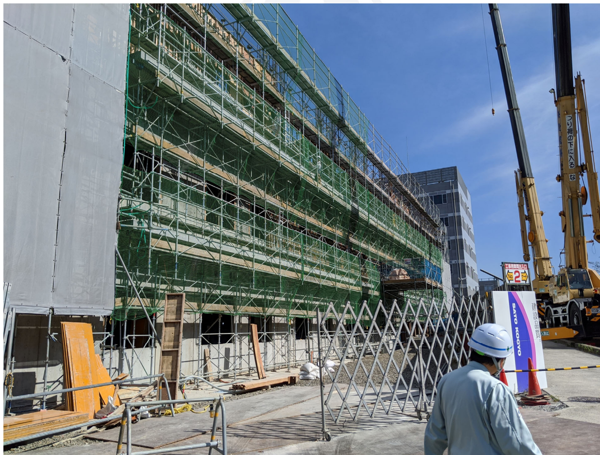
2020年5月 外部足場組立状況
