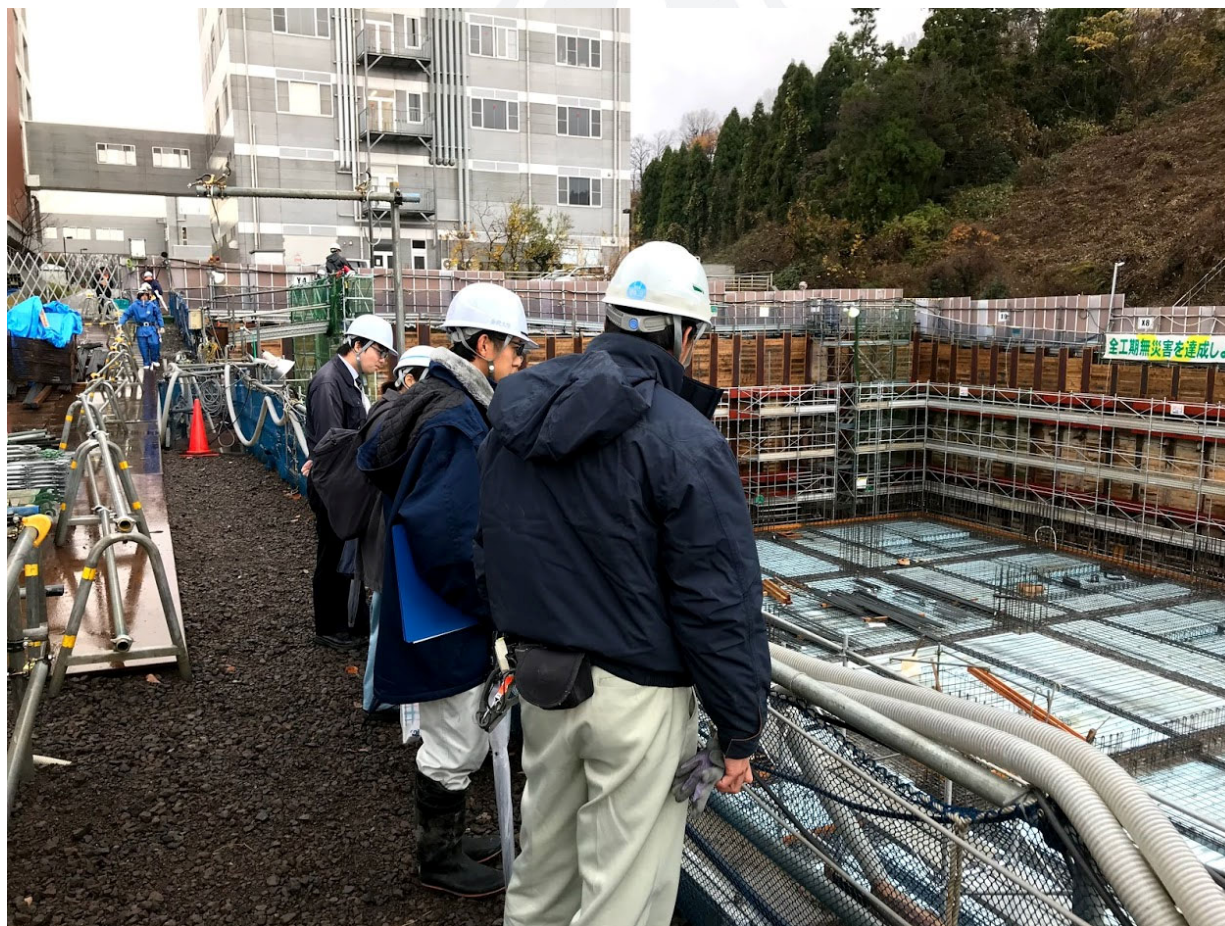
2019年12月 地下コンクリート打設前
