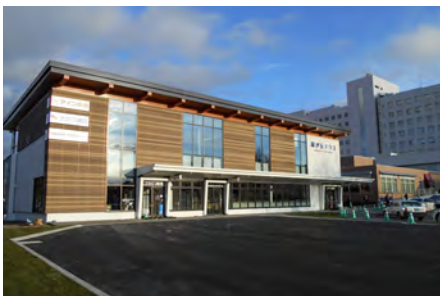
旭川医科大学 緑が丘テラス
