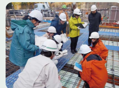
配筋検査の様子。構造に係る重要な検査です。
