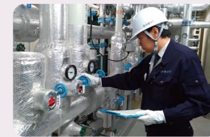
設備点検の様子。適切な維持管理により教育研究を縁の下で支えています。
